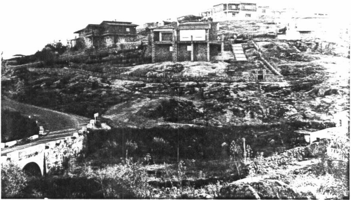
Pueblo de Santa Cruz de Pinares enclavado sobre una cúpula granítica. 83
